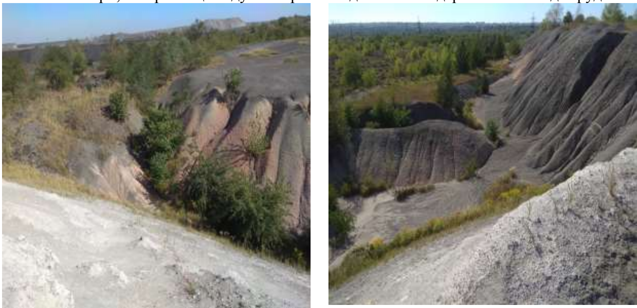
Рис 2. Лінійна ерозія захисних дамб хвостосховища
