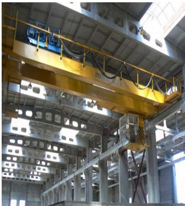
Рисунок 2 – Багатоповерхова промислова будівля з рамно-зв'язковим залізобетонним каркасом:
