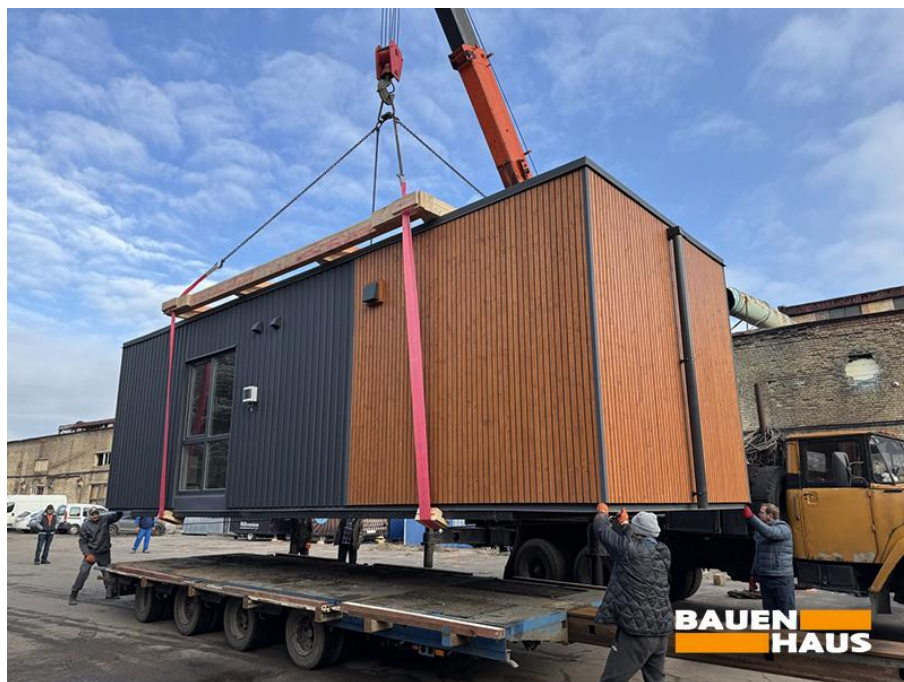
Рис. 4 Окремий модуль транспортують на будівельний майданчик
