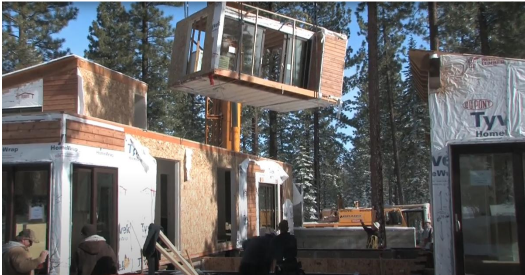
Рис. 1. Встановлення житлових модулів
